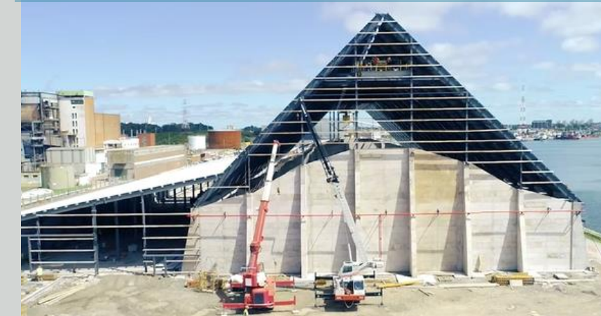
CELDA DE ACOPIO DE FERTILIZANTES DE PIER DOCE PUERTO QUEQUEN, ARGENTINA
